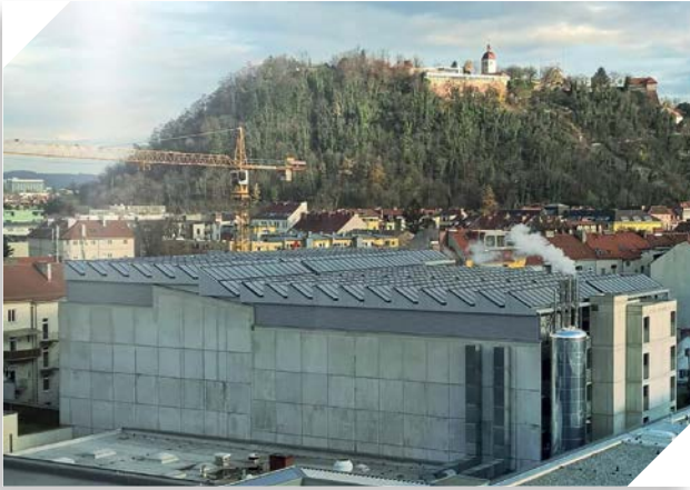
AVL hat eine 1-MW th -Solaranlage am Standort Graz über Crowdfunding finanziert.
