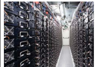
Mit einer Speicherkapazität von 14.200 kWh ist es die bislang größte Batterie in Österreich.
