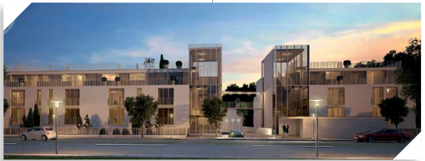
WHA Korneuburg: Graf-Holztechnik errichtet eine exklusive Anlage mit Poolhäusern.
