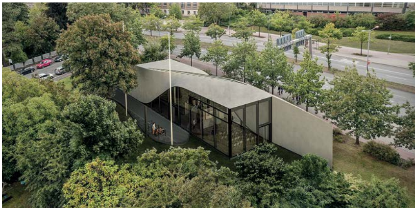
In Dresden entsteht das weltweit erste Gebäude aus Carbonbeton.
