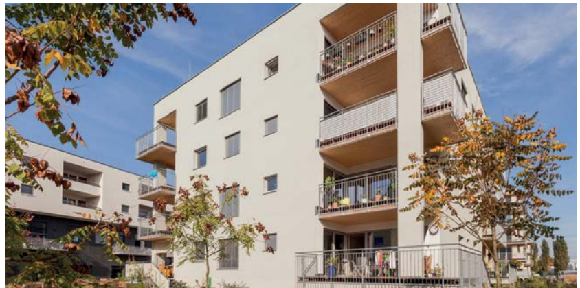
Im Plusenergieverbund Reininghaus Süd ergeben sich zahlreiche energetische Synergieeffekte, die hohe Energieeinsparpotentiale bei geringen Investitionskosten generieren.
