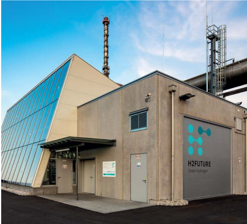
Die weltgrößte Pilotanlage zur CO 2 -freien Herstellung von Wasserstoff nahm 2019 auf dem Gelände der voestalpine den Betrieb auf. Beteiligt sind vier weitere Partnerunternehmen.
