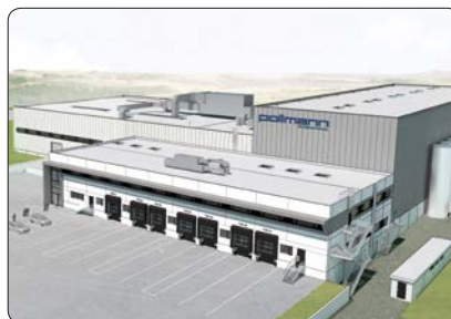
Außenansicht des Neubaus für Pollmann.
