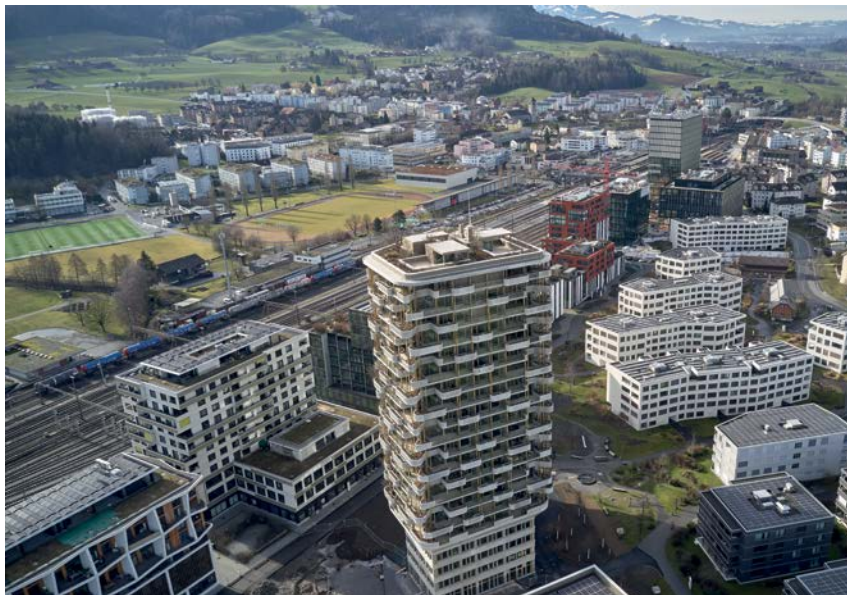
Suurstoffi nahe Zürich wird als Vorbild für ein durchmischtes, klimaneutrales Quartier gesehen, mittelfristig soll es CO 2 -frei betrieben werden.
