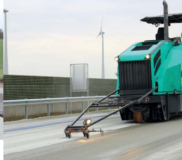
Mit Walztopping wird die Betonlösung des hochrangigen auch auf das niederrangige Straßennetz transferiert.
