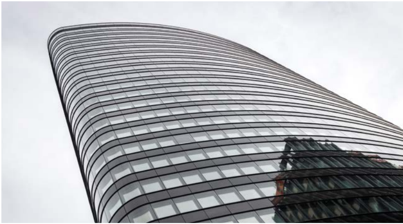
Durch die Orbi-Form mit leicht gebogenen und unten verdunkelten Fassadenelementen entsteht ein 3D-Effekt.
