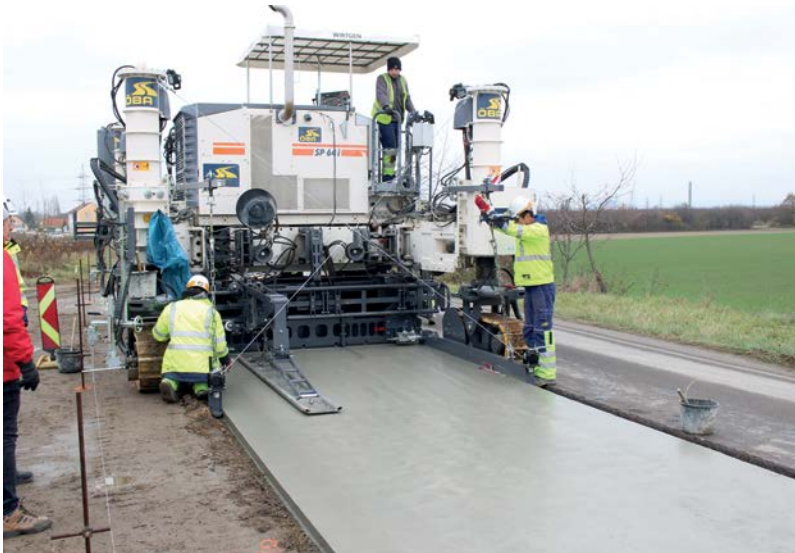
Mit Walztopping wird die Betonlösung des hochrangigen auch auf das niederrangige Straßennetz transferiert.
