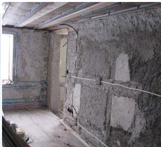
Von außen ein typisches Halleiner Altstadtthaus, innen wird auf ein modernes Energiesystem gesetzt. In den Wänden wurden umfangreiche Rohrleitungen verlegt, durch die warmes Wasser gepumpt wird, um die massiven Bauteile zu aktivieren und einen Kachelofeneffekt zu erzielen.
