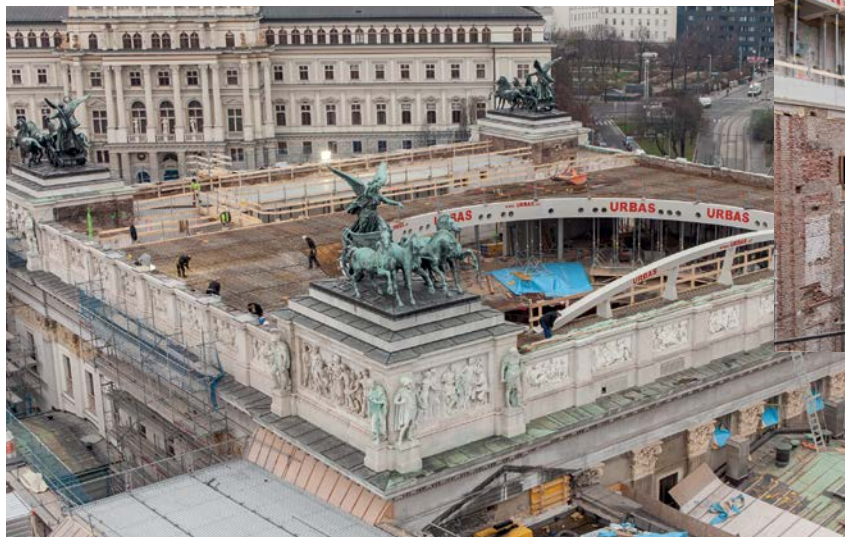
Zu den größten Herausforderungen zählt die Dachsanierung. Für die Errichtung der Glaskuppel über dem Nationalratssaal (rechts), wurde ein Stahldruckring erfolgreich montiert (Bild oben).
