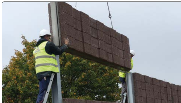
In Slowenien kommt das neue Phonobloc DB NBF-System entlang der A2 bei Višnja Gora zum Einsatz.
