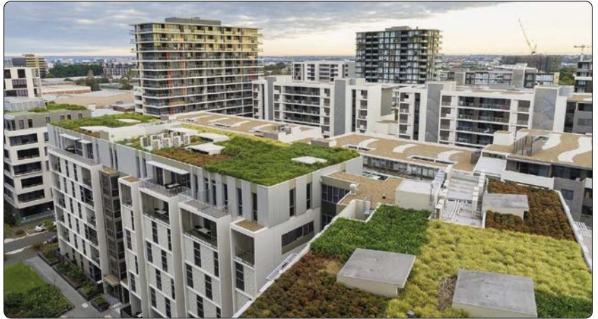
Begrünte Umkehrdächer speichern große Mengen an Kohlendioxid und verbessern das Stadtklima.
