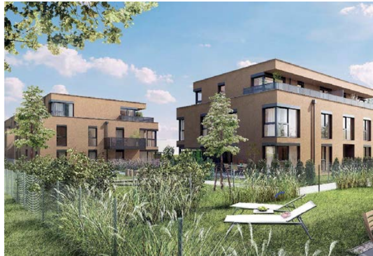
Bauteilaktivierte Decken, zentrale Luftwärmepumpen für TBA, PV-Anlage und dezentrale Warmwasseraufbereitungs-Wärmepumpen kennzeichnen die Wohnanlage Viertel hoch Zwei.
