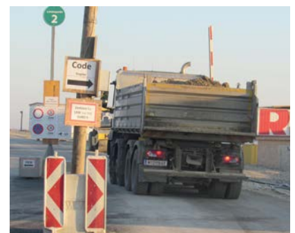
Schrankenanlagen auf der Baustelle Seestadt Aspern prüfen die Einfahrtberechtigung der LKW.
