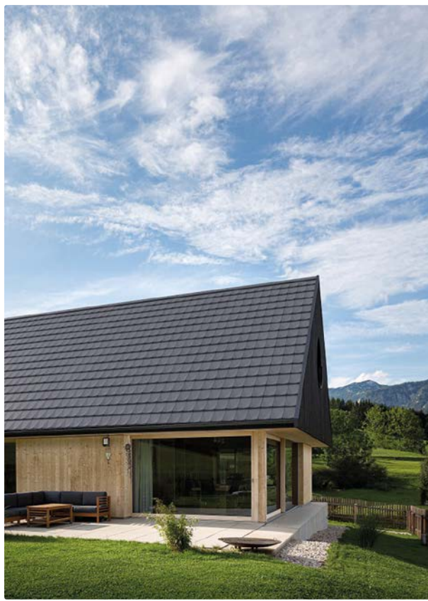
Tondach V11-Referenzhaus in Oberösterreich.
