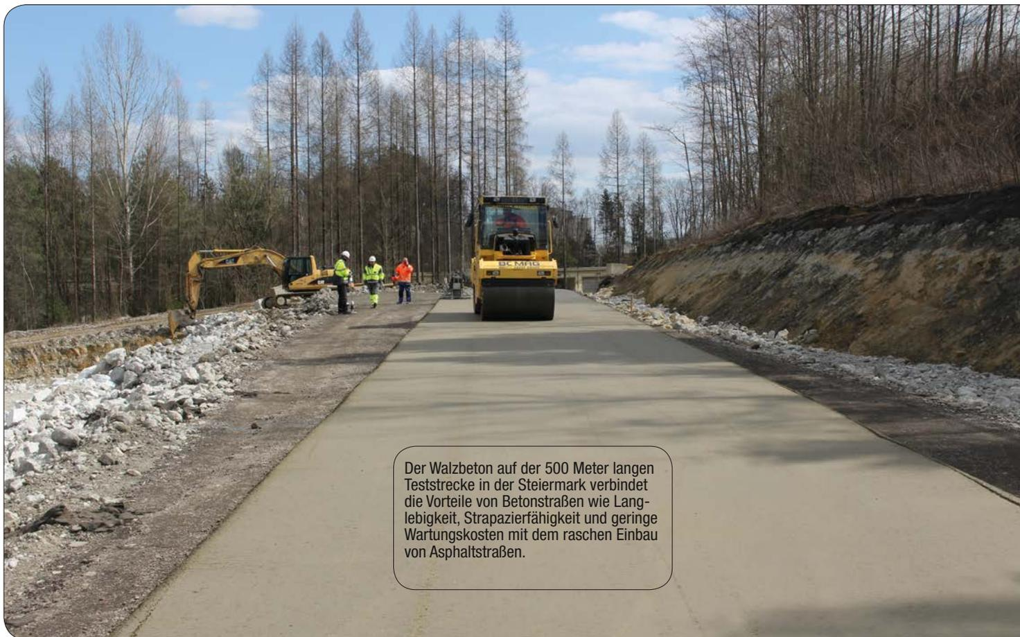
Der Walzbeton auf der 500 Meter langen Teststrecke in der Steiermark verbindet die Vorteile von Betonstraßen wie Langlebigkeit, Strapazierfähigkeit und geringe Wartungskosten mit dem raschen Einbau von Asphaltstraßen.
