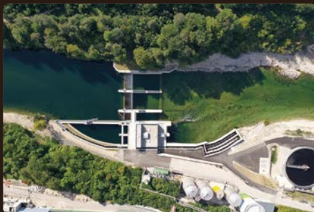
Das neue Kraftwerk Danzermühl nach 2,5 Jahren Bauzeit.
