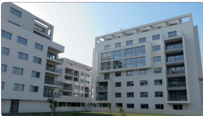
Die Wohnhausanlage Attemsgasse 31, 1220 Wien, des Österreichischen Siedlungswerkes überzeugt mit durchdachter Ökologie, zahlreichen Gemeinschaftsräumen und Wohneinheiten für unterschiedliche Lebenslagen.
