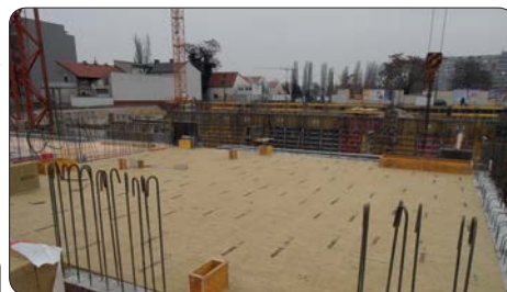
Als eines der ersten Projekte wurde die Kellerdeckenplatte Decrock in der Wohnhausanlage Attemsgasse 31, 1220 Wien im Auftrag des ÖSW eingesetzt.
