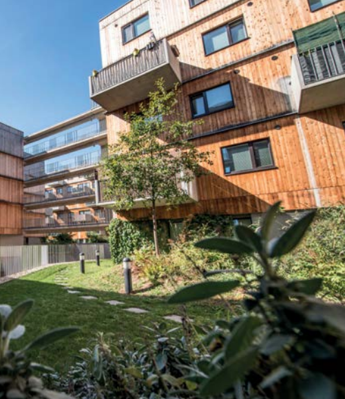
Die Gebäude in Aspern stehen in laufendem Austausch mit Mess- und Kontrollstationen.
