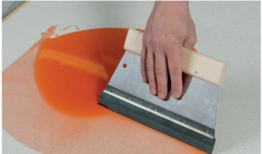
Die 1-komponentige, ökologische Silan-Feuchtigkeitssperre MS-X 3 von Murexin ist die verarbeiterfreundliche Alternative zu Produkten auf Epoxid- und Polyurethanbasis.
