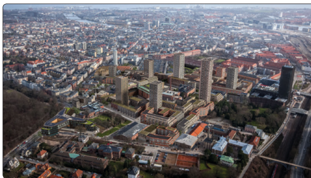
Die dänische Strabag-Tochter Züblin baut weitere 49.000 m 2 im Carlsberg-Quartier in Kopenhagen.
