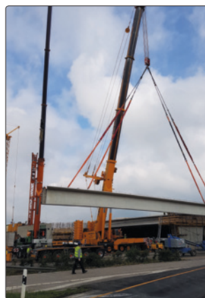
Spannbetonträger von 36 Metern Länge. Die Fertigteilform wurde mit 24 alkus®-AL-20-Platten mit insgesamt gut 200 Quadratmetern Fläche konstruiert.
