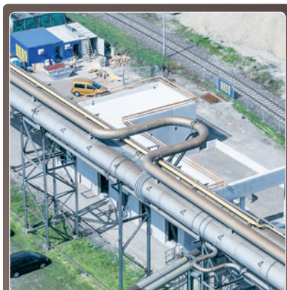
In Linz entsteht derzeit die größte und modernste Elektrolyseanlage zur Erzeugung von CO2-freiem Wasserstoff.
