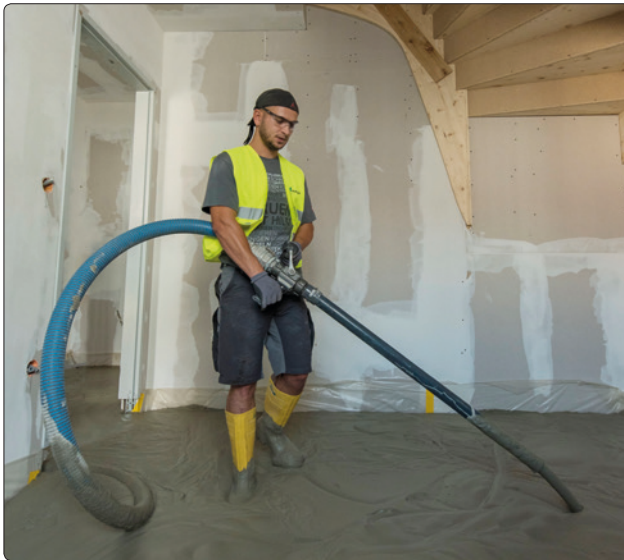
AIRIUM vereint Ausgleichsschüttung und Estrichdämmung in einem Arbeitsschritt.
