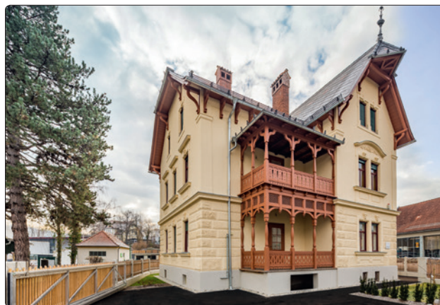
Die Veranden an der Straßen- und Hofseite zeichnen sich durch handwerklich fein ausgearbeitete Zierschnittmotive an der Stützkonstruktion und schmückenden Holzstützen aus. Um den authentischen Holzfarbton wieder zu beleben, kam eine Histolith-Leinölfarbe zum Einsatz.
