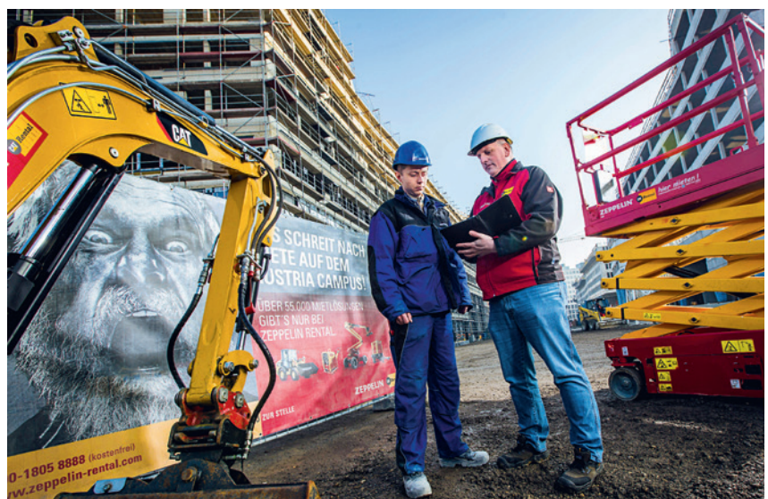
Am Projekt Austria Campus hat Zeppelin Rental die erste temporäre Mietstation eingerichtet. Die Kunden ersparen sich Anfahrtswege und können kurzfristig Geräte ausleihen und wieder retournieren.
