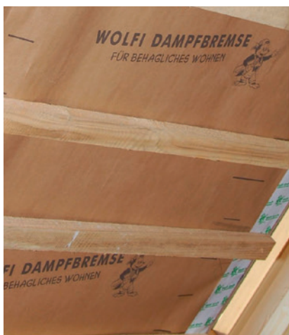
Die Zellulosedämmung »Wolfi-Dampfbremse« ist eine gitterverstärkte Kraftpapier-Dampfbremse für behagliches Wohnklima.
