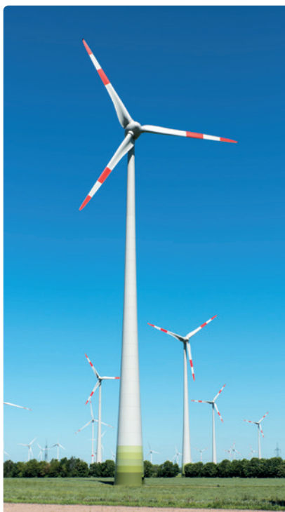
Windräder erzeugen heute 11 % des gesamt-österreichischen Stromverbrauchs.
