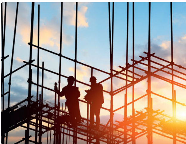
Gute Aussichten: Im April 2018 haben mehr Bauunternehmen als je zuvor ihre Auftragslage über dem normalen Niveau liegend eingestuft.
