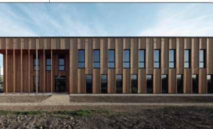
Neben der natürlichen Optik wird durch den Baustoff Holz auch das Raumklima verbessert.
