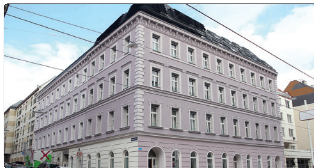
Die Sanierung des Gründerzeithauses in der Mariahilfer Straße wurde von der Stadt Wien mit 4,4 Millionen Euro gefördert
