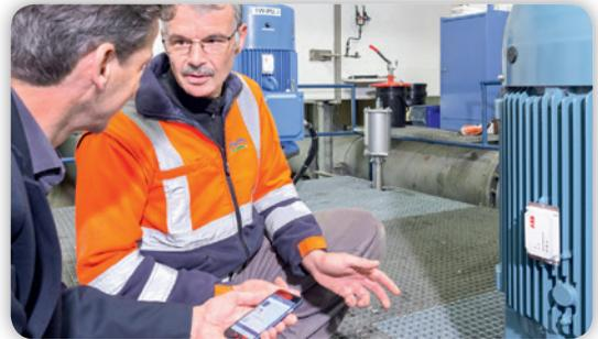
IN ZUSAMMENARBEIT mit dem Schweizer Pumpenhersteller Egger entwickelt ABB den »ABB Ability Smart Sensor« für die Fernüberwachung von Pumpen weiter.
