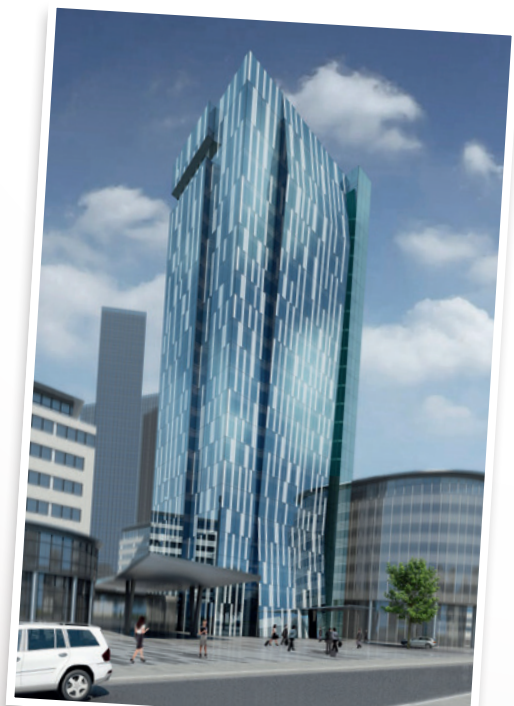
Fotos: Holzbauer und Partner Architekten ZT-GmbH NOVUM Hotel (Tag Immobilien), ZOOM VP (UBM), beigestellt
