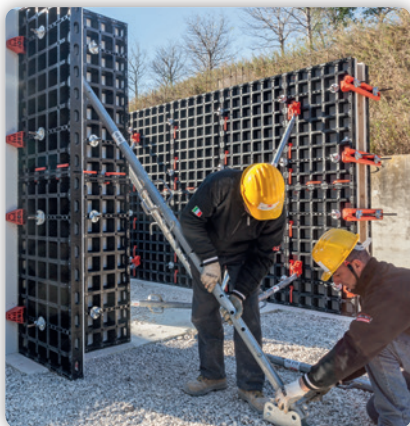
BEIM SCHALUNGSSYSTEM DUO verwendet Peri statt Holz, Stahl oder Aluminium einen speziell entwickelten und deutlich leichteren Kunststoff.
