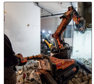
Rohr-Bau benötigte den Abbruchroboter für den Rückbau der Wand, den E-Radlader für den Abtransport des abgebrochenen Materials.
