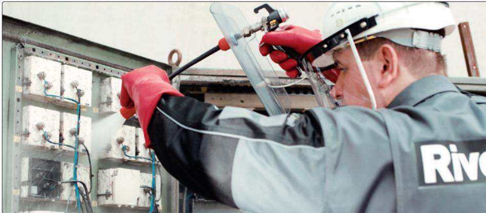
Die Nassreinigung unter Spannung ermöglicht das Arbeiten an elektrischen Anlagen auch dann, wenn sie nicht vom Netz genommen werden können.
