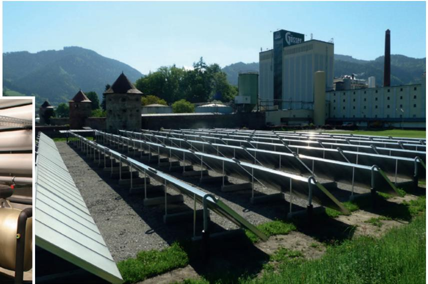
90 Prozent der während des Produktionsprozesses entstehenden Abwärme werden in der Brauerei Göss genutzt, um Wasser aufzuheizen. Die 1.500 m<sup>2</sup>-Solaranlage erzeugt einen Teil der benötigten Wärme für den Maischeprozess.
