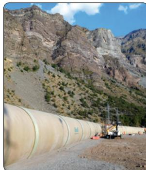
Lösung von Hobas aus glasfaserverstärktem Kunststoff mit einer deutlich geringeren
