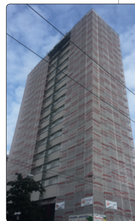
Fassadensanierung mit Ringer-Doppelgeländer-Gerüst beim höchsten Gebäude der Stadt Salzburg.
