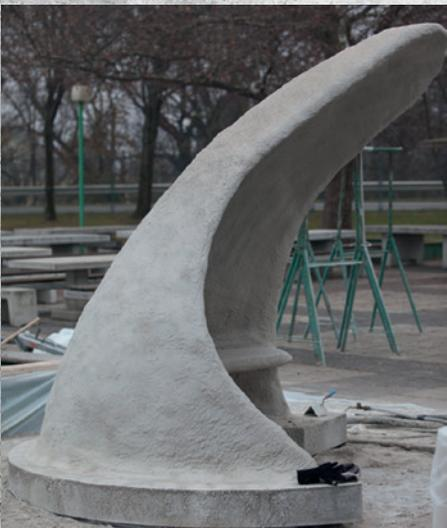
**Die gebogenen Kunststoffteile** werden platzsparend auf die Baustelle geliefert, vor Ort zusammengesteckt und das so entstandene Gerüst mit einer Kunststoffschicht überzogen und mit Spritzbeton ummantelt.
