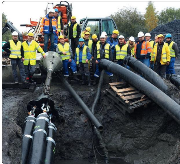
Verlegt wurde eine Rohrleitung mit Innenwellrohren aus Edelstahl, welche die thermisch bedingte Längsausdehnung der Rohrleitung kompensieren können.
