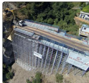
Nichts für schwache Nerven ist die temporäre Fahrbahn, die für den Bau einer Brücke im schweizerischen Stalden errichtet wurde.
