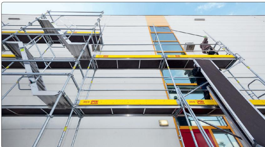
Peri Up Easy ist ein »Leichtgewicht« unter den Stahl-Fassadengerüste und bietet Sicherheit im System.
