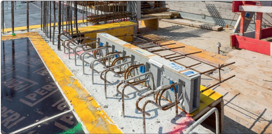
Beim »RONDO« im Viertel Zwei kommen 2.500 Stück Isokorb von Schöck für die wärmebrückenarme, konstruktiv einfache und statisch wirtschaftliche Befestigung zum Einsatz.
