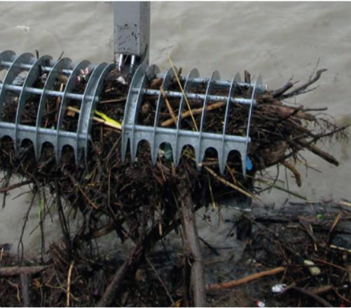
Die Rechenreinigungsmaschine sammelt Verunreinigungen wie Äste, Laub und Müll – hier im Einsatz beim Kraftwerk Lehen.
