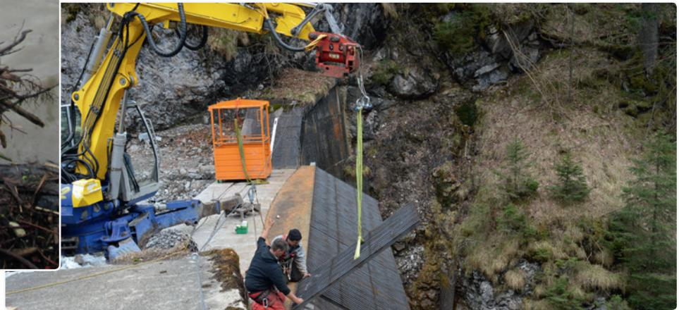
Der Coanda-Rechen ist eine selbstreinigende Wasserfassung mit einem Feinrechen mit hohem Schluckvermögen.
