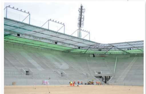
Die Arbeiten im Stadion gehen zügig voran.
