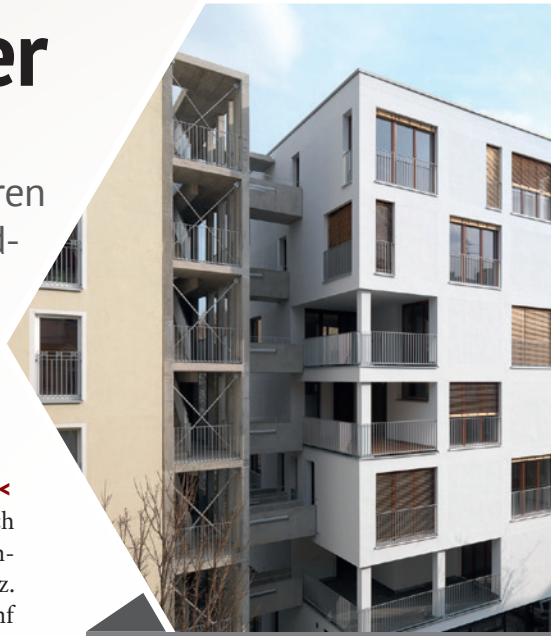
Da e3 in Berlin ist die erste siebengeschoßige Holzkonstruktion in einem großstädtischen Zentrumsbereich Europas.
