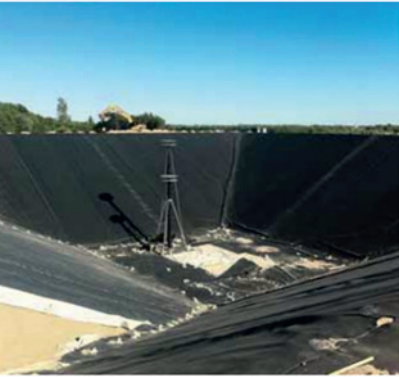
Erdbeckenspeicher Dronninglund, 61.700 m 3 .
