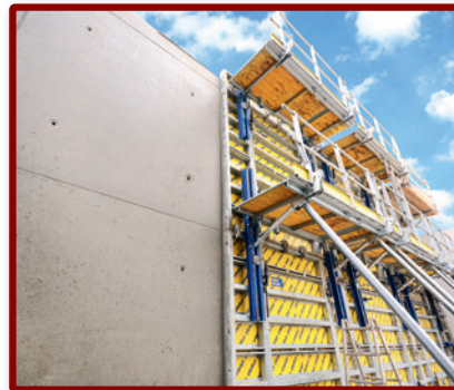
Die Rahmenschalung Framax Xlife plus bringt bis zu einem Drittel Zeitersparnis.
