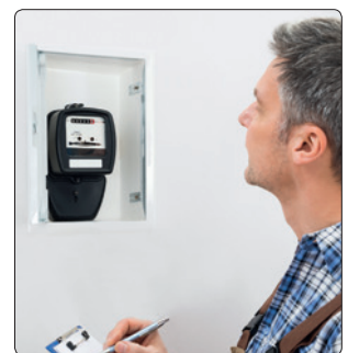
Ablöse der Ferraris-Zähler und manuellen Zählerstandangaben.
