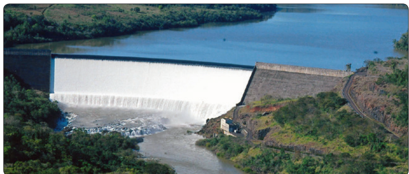
Andritz modernisiert Wasserkraftwerke in Südamerika in einem Gesamtwert der Aufträge von rund 70 Millionen Euro.
