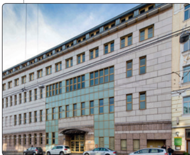
Bis Herbst 2016 entsteht in der Althanstraße im neunten Wiener Gemeindebezirk das neue Arbeits- und Sozialgericht.
