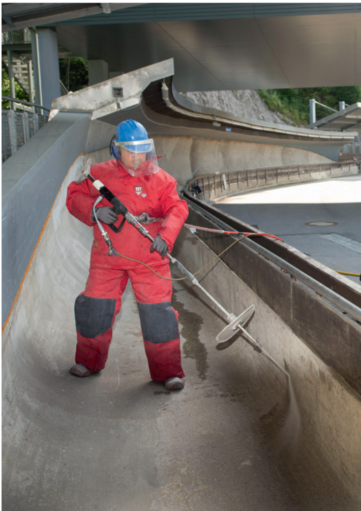
EcoMaster MK 3 ist ein Höchstdruck-Wasserstrahl-System zur Reinigung von Bauwerken und industriellen Anlagen.
