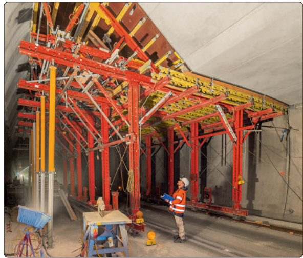
VARIOKIT erlaubt maßgeschneiderte Tunnelschalwagen mit standardisierten Bauteilen für jede Tunnelbauweise und jeden Querschnitt.
