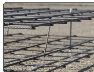
Bewehrungskorb der neuen MABA-Korbwand.
