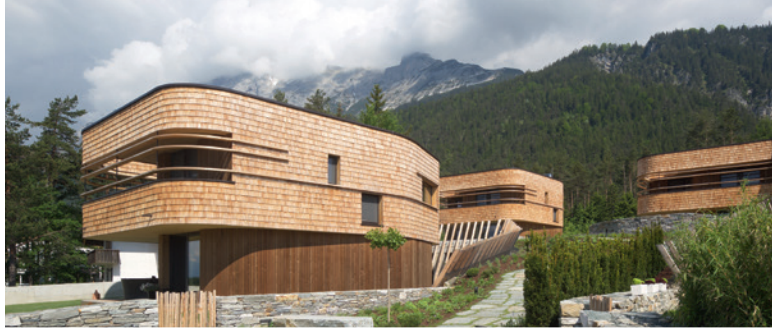
Die Wohnhausanlage »Vierklee« in Gnadental (Tirol) ist sowohl durch ihre Architektur, als auch durch die großzügige Freiraumgestaltung geprägt. Alle vier Baukörper erreichen klimaaktiv Gold Standard.
