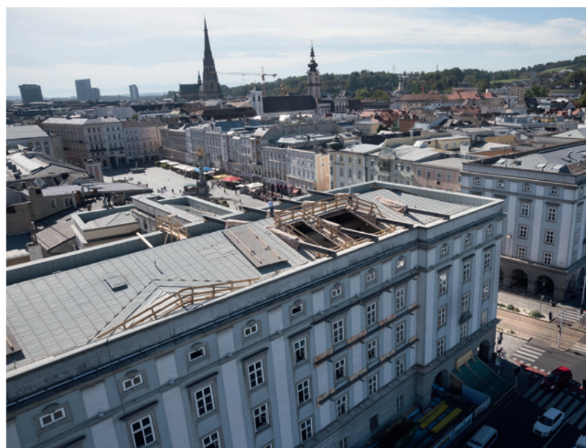
Die Linzer Brückenkopfgebäude werden nach den Plänen von Architekt Krischanitz ZT GmbH saniert.
