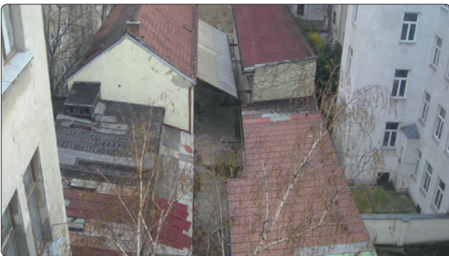
Die Siebenbrunnengasse 72 vor und nach der Sanierung.
