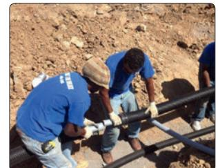
Die Kunststoffleitungen bestehen aus vollständig recycelbaren Polyolefinen. Sie lassen sich kostengünstig verlegen.
