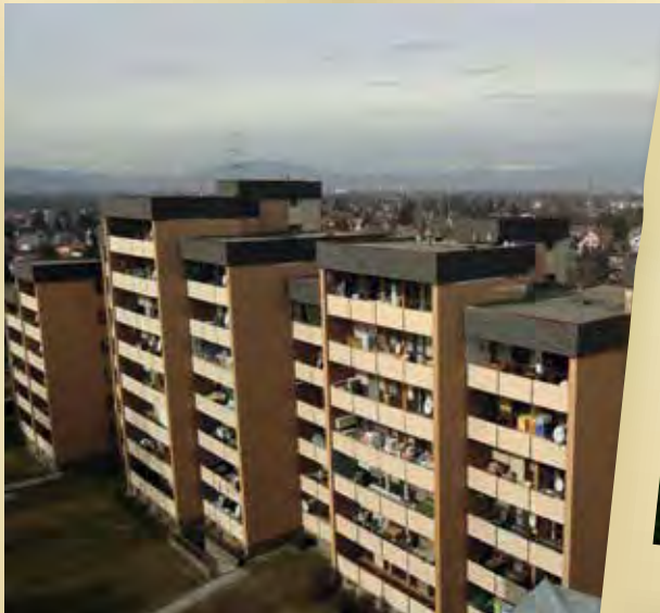
Vorher – Nachher: Fassadensanierung in Graz-Liebenau.
