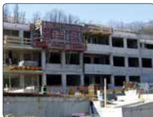
Ringer-Schalungen auf der Baustelle »Waldmühle Rodaun«.
