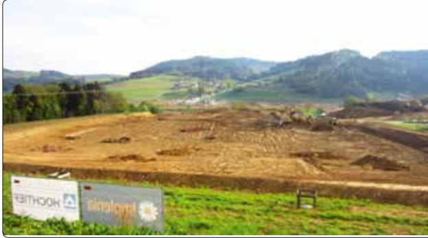
Erdarbeiten bei der Einhausung Granitztal.
