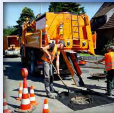
**Asphalt-Thermo-Container** sind beheizt und isoliert. Fassungsvermögen: 2,5–20 t. Asphalt.
