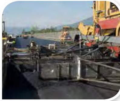
Ein Kompaktasphaltfertiger reduziert die Einbauzeit, verringert den Materialeinsatz und erhöht die Qualität.
