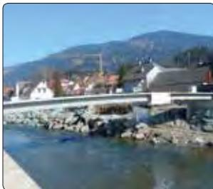
Die schlanke Silhouette, die rasche Bauzeit und die lange Lebensdauer gaben den Ausschlag für eine Fertigteilbrücke aus hochfestem Spezialbeton.
