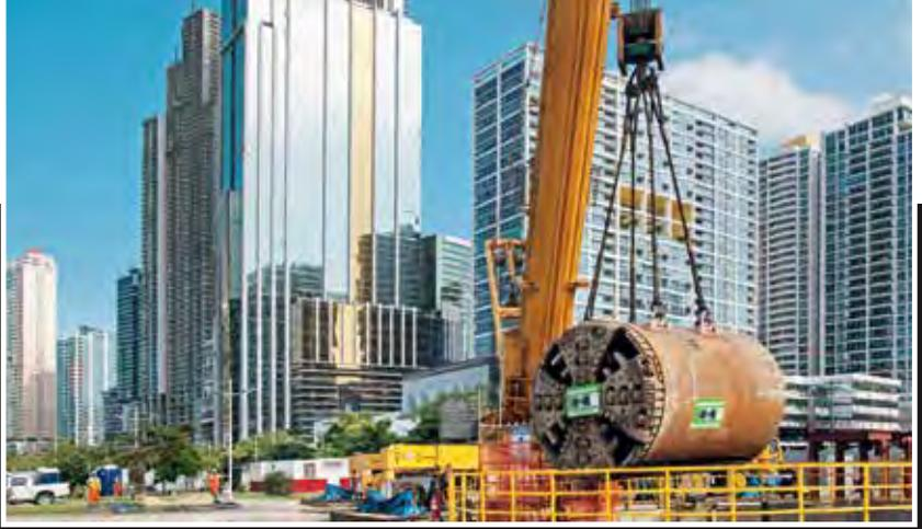
**Microtunnelling** beschreibt ein grabenloses Tunnelbauverfahren, bei dem eine unbemannte Tunnelvortriebsmaschine im Rohrvortrieb von einem Steuercontainer an der Oberfläche ferngesteuert wird.
