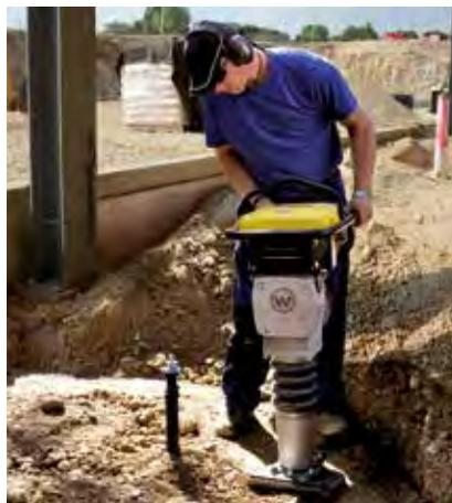
Der Akkustamper AS 50 von Wacker Neuson mit einem Antrieb aus Akku und Elektromotor arbeitet völlig emissionsfrei.
