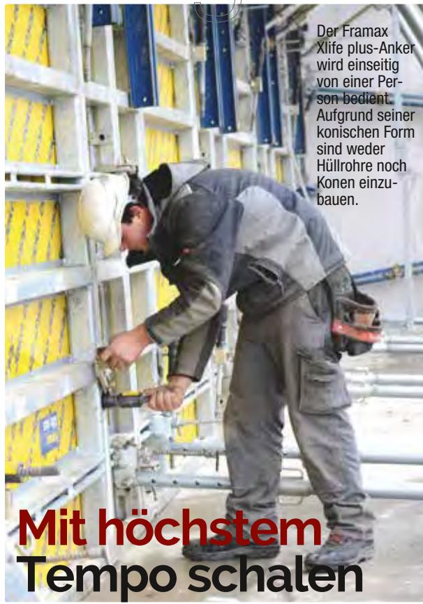
Der Framax Xlife plus-Anker wird einseitig von einer Person bedient. Aufgrund seiner konischen Form sind weder Hüllrohre noch Konen einzubauen.
