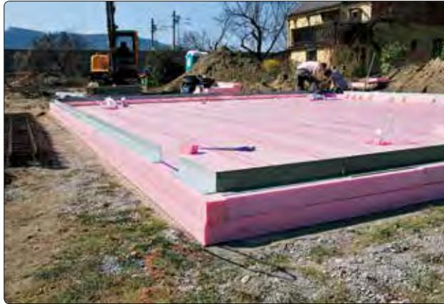
Das »Austrotherm Fundamentplatten-Dämmsystem« kommt unter Bodenplatten zum Einsatz, die hohem Druck ausgesetzt sind, wie etwa im Wohnungsbau.
