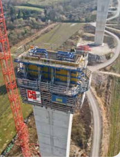
Hünnebeck zeichnet für die Schalungslösungen von Deutschlands größtem Brückenbauprojekt verantwortlich.
