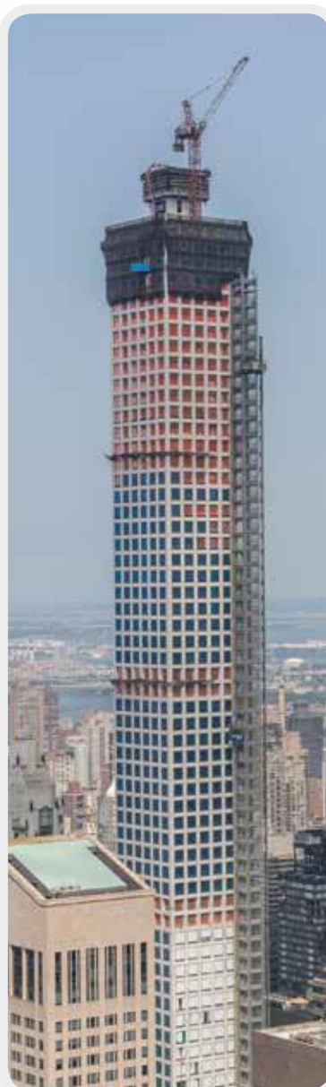
Mit 426 m wird der 432 Park Avenue Tower in New York das höchste Wohngebäude der westlichen Hemisphäre.
