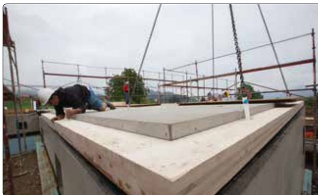
Der erste Prototyp einer Holz-Beton-Verbunddecke im Einsatz.
