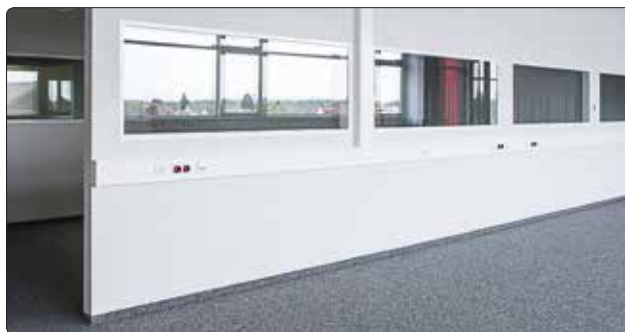
Beim Ausbau des Anton-Paar-Werks in Graz wurden 80 EasyWin-Fertigfenster für Trockenbauwände eingebaut.
