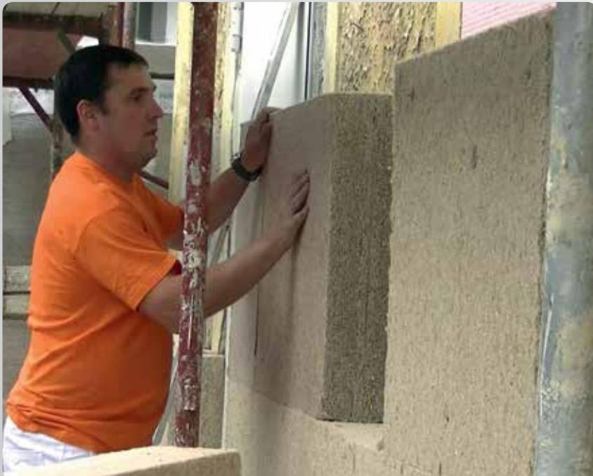
»Die Dämmwerte von Hanf sind gleichwertig wie EPS-Dämmstoffe. Hanf hat allerdings einen deutlich besseren Schallschutzwert und ist ein reines Naturprodukt aus Österreich«, ist man bei Capatect überzeugt.
