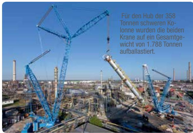
Für den Hub der 358 Tonnen schweren Kolonne wurden die beiden Krane auf ein Gesamtgewicht von 1.788 Tonnen aufballastet.
