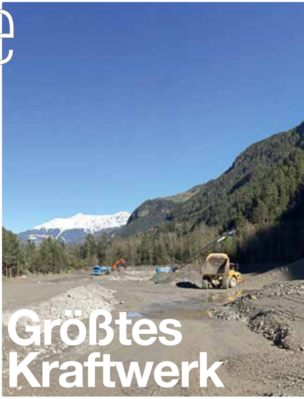
Baustelle des Gemeinschaftskraftwerks Inn in Maria Stein. Am 14. November erfolgte der Spatenstich.
