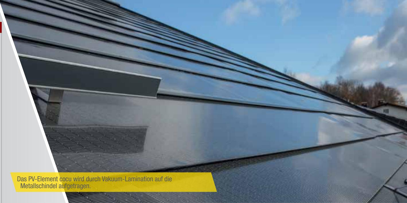
Das PV-Element cocu wird durch Vakuum-Lamination auf die Metallschindel aufgetragen.
