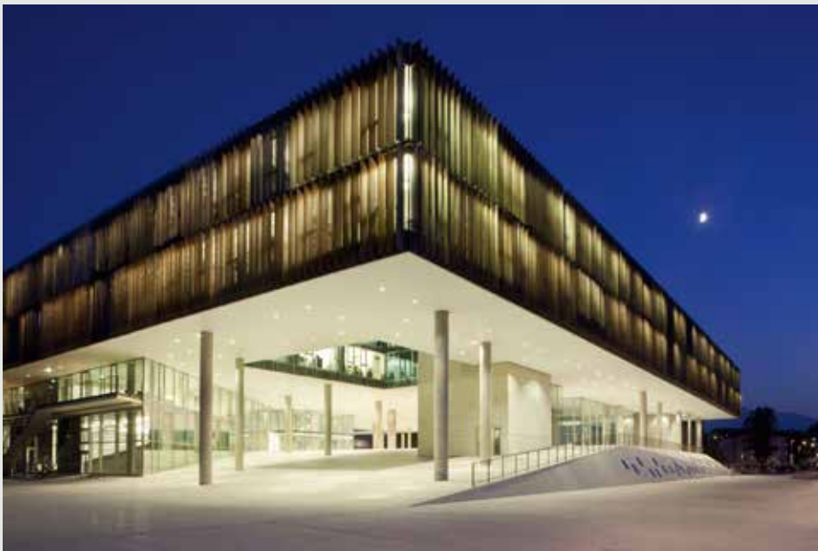
Der 2012 eröffnete Unipark Nonntal kombiniert moderne Architektur mit effizienter Gebäudetechnik. Statt herkömmlicher Jalousien sorgen beispielsweise hunderte Metalllamellen für die gewünschten Lichtverhältnisse.
