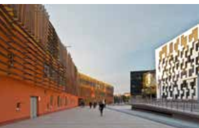
Rund 8.000 m 2 Hightech-Fassade stammen beim D3/AD von Sto.
