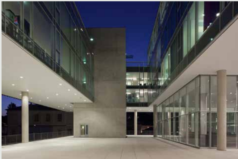
Licht und Beschattung sowie Heizung und Klimatisierung werden über ein durchgehendes Raumautomationssystem gesteuert, das dazu mit rund 11.700 Datenpunkten kommuniziert.
