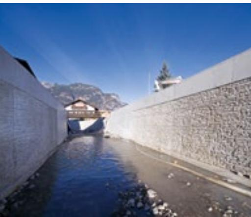
Die betonierten Seitenwände sind mithilfe von NOEplast Strukturmatrizen einem Natursteinmauerwerk nachempfunden.
