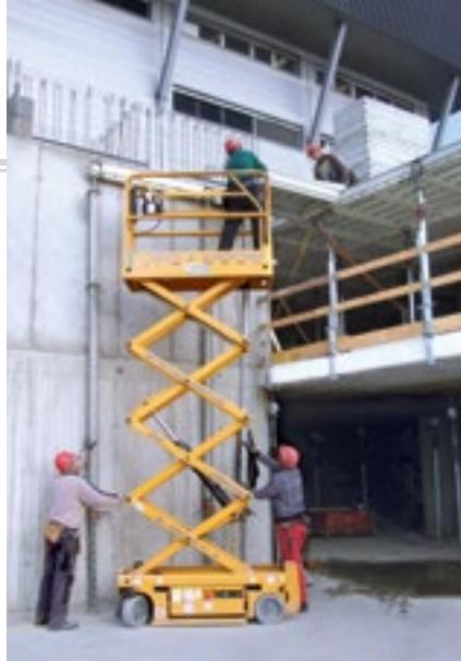
Zuerst werden die Stützen aufgestellt, dann die Hauptträger von einer Scherenhebebühne aus eingehängt und die Elemente eingelegt.
