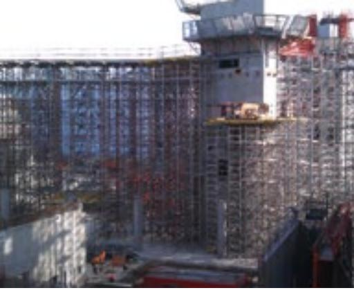
Sämtliche für den Rohbau der neuen Pariser Philharmonie benötigten Traggerüst- und Unterstützungslösungen werden von Harsco entwickelt, geliefert und montiert.
