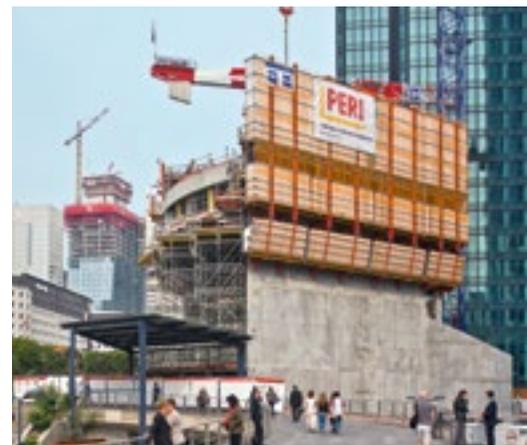
Die Peri-Kletterschalungslösung dient zum einen als Einhausung und damit der Sicherheit des Baustellenteams. Zum anderen unterstützt sie Fertigteilbrüstungen während der Montage.
