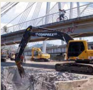
Mithilfe von Atlas Copco-Maschinen wurde eine aus 1.300 m<sup>3</sup> armiertem Beton bestehende alte Brücke entfernt.
