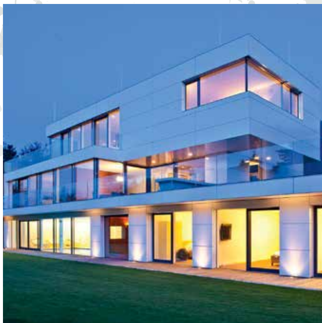
Vorgehängte, hinterlüftete Fassaden können helfen, den Wärmeeintrag im Inneren eines Gebäude zu minimieren.
