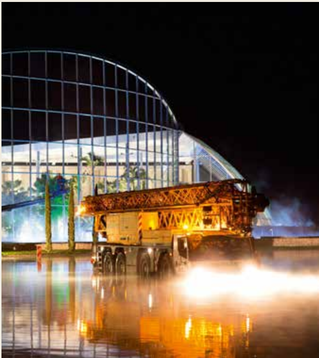
Heikle Renovierungsaufgabe in Sinsheim für den Mobilbaukran MK 88 von Liebherr.
