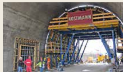
Der robuste Schalwagen DokaCC legte bei der Herstellung des Grüntunnels fast 500m zurück.
