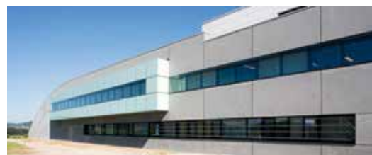
Beständigkeit mit Sichtbeton.
