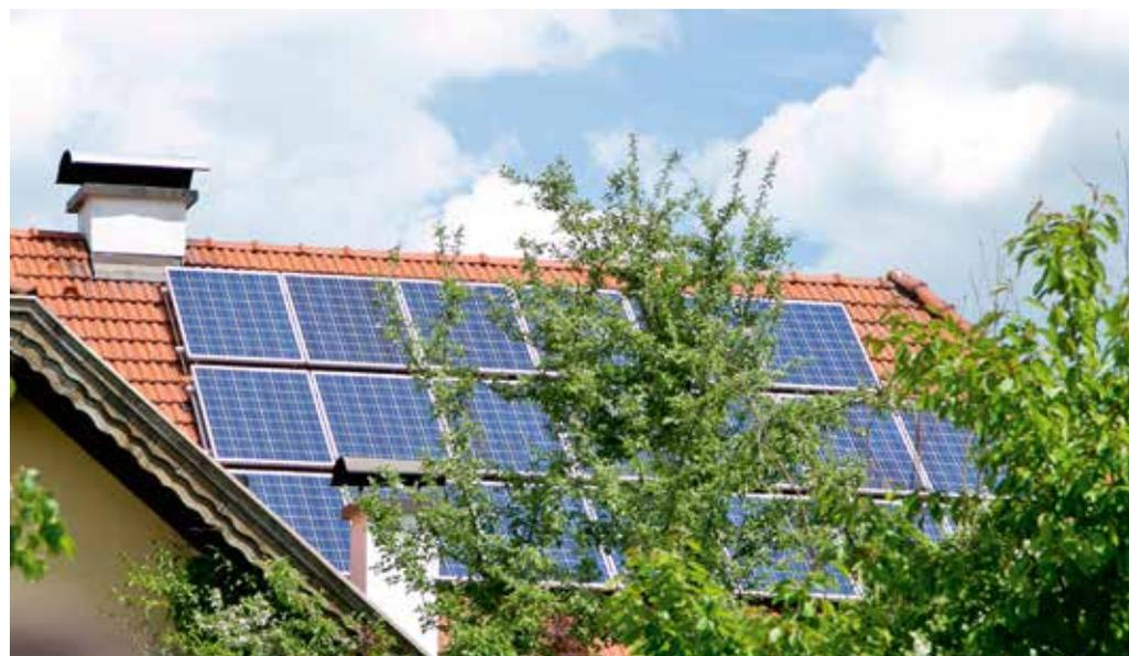
**DER OUTPUT DER PV-ANLAGEN** in Köstendorf wird in einer lokalen Trafostation gebündelt. Scheint die Sonne, werden gut 75 % des Strombedarfs abgedeckt.
